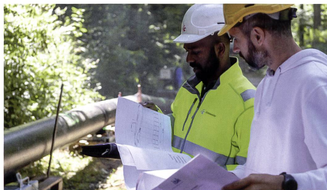
Die Bauleitung vor Ort gehört zum Arbeitsalltag der Ingenieure.
