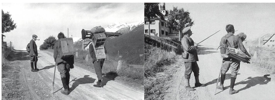
Abb. 3: Die Ausrüstung des Schrauben-Mikroskop-Theodoliten wiegt total 49 kg und muss von zwei Gehilfen getragen werden. Die Wild'sche Ausrüstung dagegen ist nur 17 kg schwer und kann von einem Mann leicht getragen werden.
