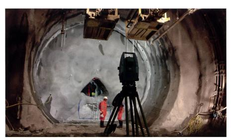
Abb. 6: Bei Bau und Überwachung des Gotthard-Basistunnels der NEAT, mit 57 km längster Eisenbahntunnel der Welt, kommen verschiedene Leica Geosystems-Instrumente zum Einsatz, z.B. Totalstationen, GPS-Systeme und Digitalnivelliere. Die Abweichung auf die gesamte Distanz betrug nur wenige Zentimeter.
