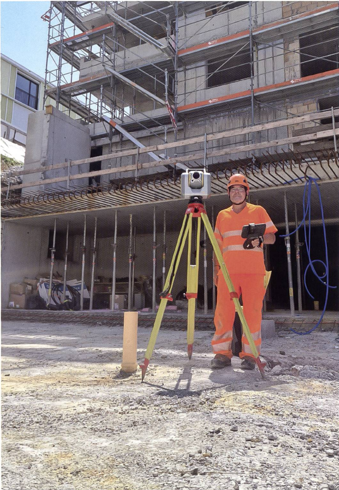
Bauvermessung im Einmann-Betrieb mit der Trimble SX12 (Bild: Terradata AG, Pfäffikon/SZ).
