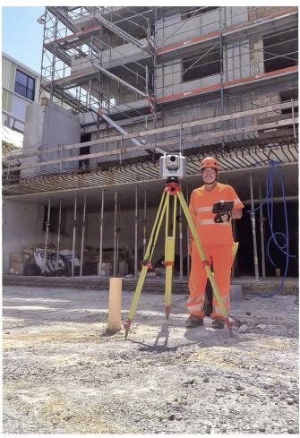
Bauvermessung im Einmann-Betrieb mit der Trimble SX12 (Bild: Terradata AG, Pfäffikon/SZ).
