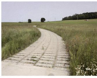
Fig. 2: Détail de la construction du chemin en plots de béton (photo: Ph. Grosvernier).
