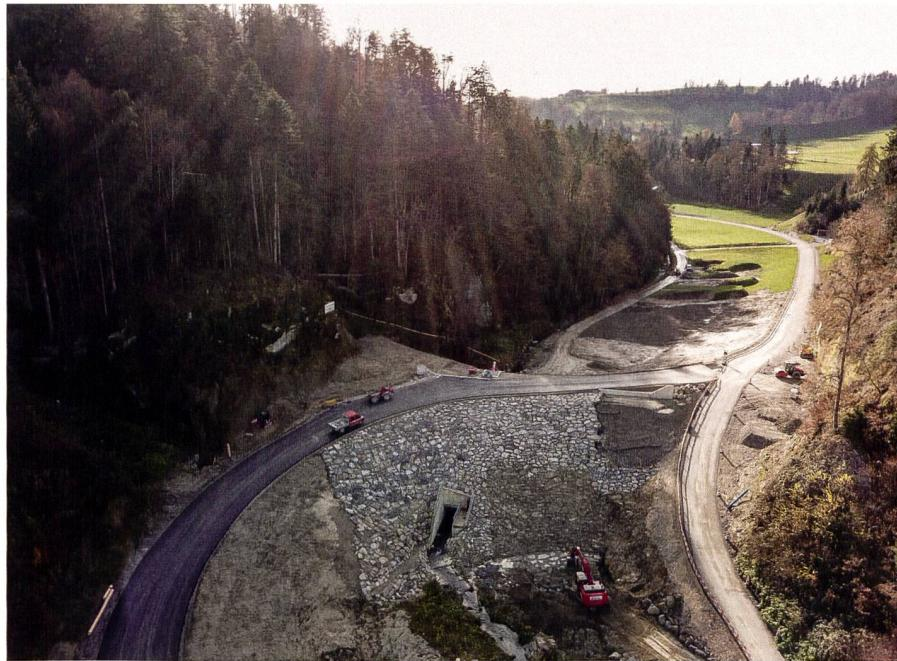
Abb. 2: Sicht auf die Talseite des Hochwasserschutzbauwerks und den Einstaubereich im oberen Teil des Fotos.
