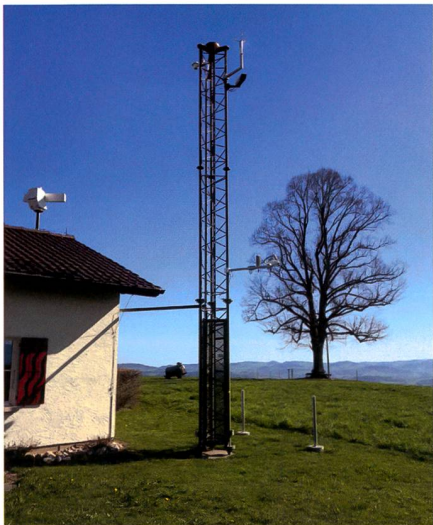
Abb. 3: Geostation Zimmerwald: Antennenmast der permanenten GNSS-Station des AGNES-Netzes, auf dem Fundamentalpunkt der LV (Foto swisstopo).
