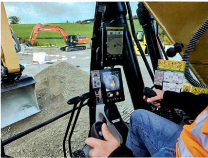
Abb. 10: Anwendungsbereich von swipos®: GNSS-gestützte Echtzeit-Positionierung einer Baumaschine, inkl. automatischer Steuerung der Grabtiefe. Monitor im Cockpit (Trimble Earthworks; Foto Sitech Schweiz AG).
