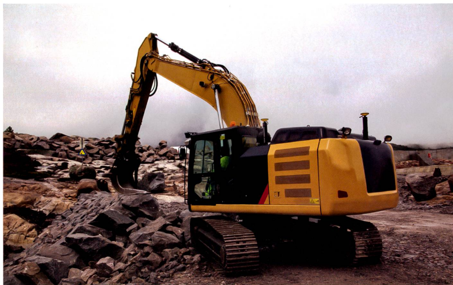
Fig. 10: Champ d'application de swipos®: positionnement en temps réel par GNSS d'une machine de construction (photo Leica Geosystems SA, Suisse).
