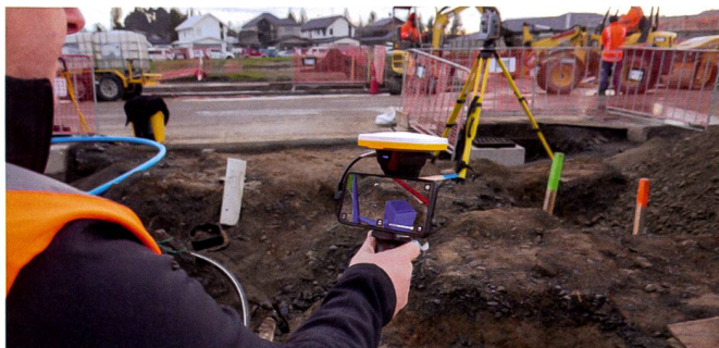
Einbaukontrolle und gleichzeitige Dokumentation.
