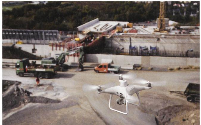
stellen, beispielsweise für die Flugroute der Drohne. Dabei können Parameter wie Überlappungsrate, Flughöhe, Fluggeschwindigkeit und Kameraeinstellungen eingestellt werden. Zudem bietet ALLNAV verschiedene Softwareanwendungen und -services, mit denen die Datenauswertung und -aufbereitung schnell und präzise ausgeführt werden kann.
