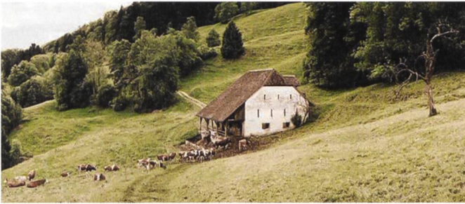
Abb. 2: Den denkmalgerechten Erhalt sicherstellen (Feldscheune bei Langenbruck BL). Dank ihrer einfachen Bauweise und den verwendeten lokalen Materialien lassen sich traditionelle Nutzbauten mit bescheidenen Mitteln erhalten. Die Landwirtschafts- und Landschaftspolitik muss dieses zumeist private Engagement ganzheitlich unterstützen.
