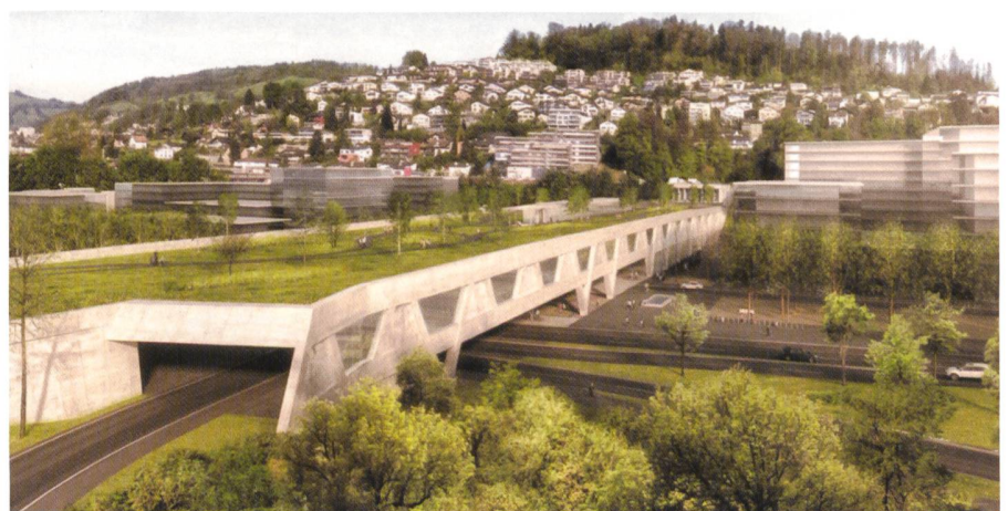
Abb. 7: Überdeckung des Tunnelportals des neuen Autobahnbypasses.
