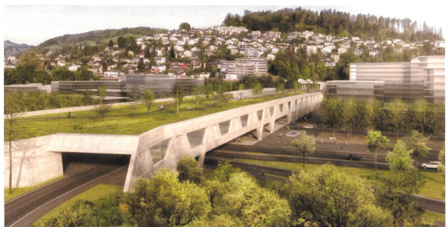
Abb. 7: Überdeckung des Tunnelportals des neuen Autobahnbypasses.
