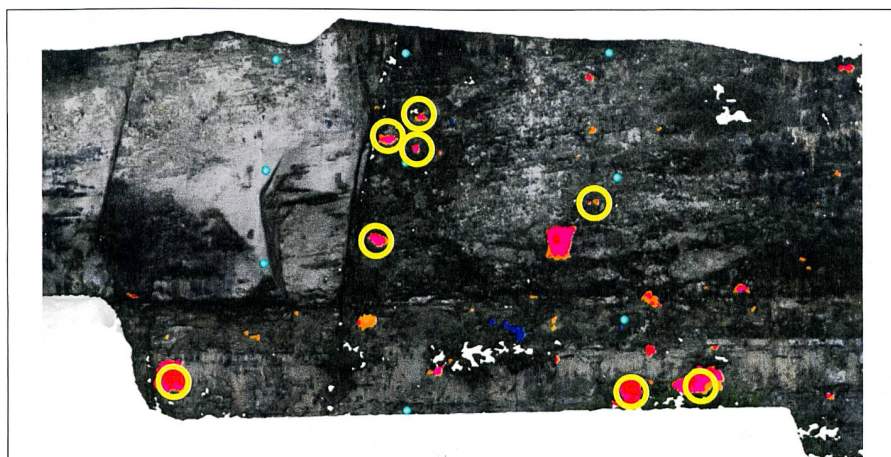
Fig. 6: Inspection E1 – E2 (cercles jaunes = décrochements).
