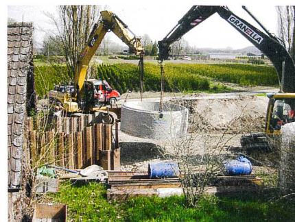
Abb. 7 und 8: Versetzen des Pumpenschachtes des neuen Entwässerungspumpwerkes.
