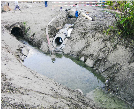
Abb. 9: Auslaufbauwerk des neuen Entwässerungspumpwerkes.
