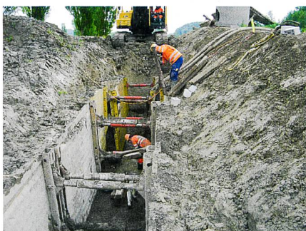
Abb. 10: Neue Hauptleitung zum Entwässerungspumpwerk in 4 m Tiefe.
