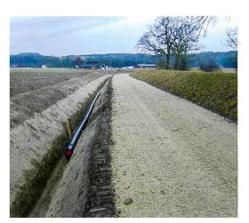
Abb. 17: Bau der Versorgungsleitung.
