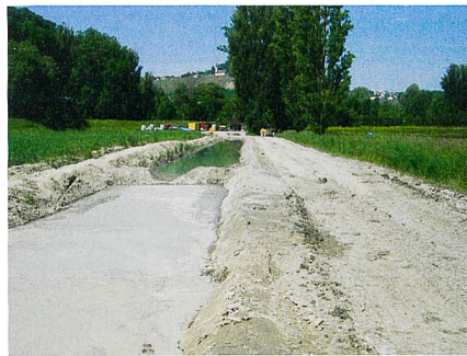
Abb. 11: Absetzbecken im Grabenstrasse.
