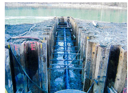
Abb. 14: Bewässerungspumpwerk, Zubringerleitung aus dem Rhein.
