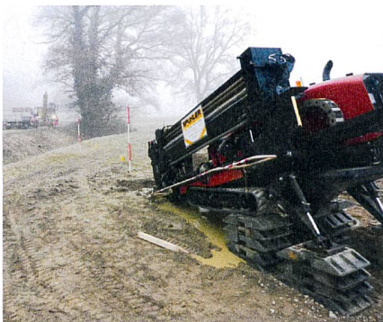
Abb. 16: Spülbohrung unter Holenrütigraben (öffentliches Gewässer).
