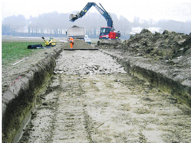
Abb. 3 und 4: Strassenbau, Verstärkung des Oberbaus mit Bollensteinen und Geotextil.
