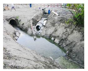
Abb. 9: Auslaufbauwerk des neuen Entwässerungspumpwerkes.
