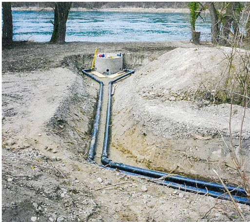
Abb. 15: Bewässerungspumpwerk, Pumpenschacht mit angeschlossenen Druckleitungen.
