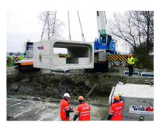
Abb. 5 und 6: Brückenersatz mit vorfabrizierten Elementen.
