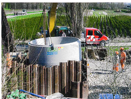
Abb. 7 und 8: Versetzen des Pumpenschachtes des neuen Entwässerungspumpwerkes.
