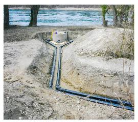
Abb. 15: Bewässerungspumpwerk, Pumpenschacht mit angeschlossenen Druckleitungen.
