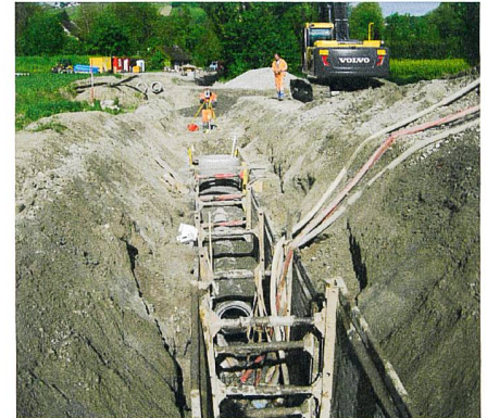
Abb. 13: Neue Hauptleitung zum Entwässerungspumpwerk in 4 m Tiefe.
