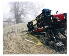
Abb. 16: Spülbohrung unter Holenrütigraben (öffentliches Gewässer).
