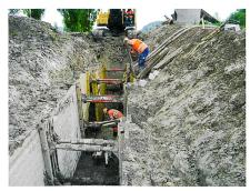
Abb. 10: Neue Hauptleitung zum Entwässerungspumpwerk in 4 m Tiefe.
