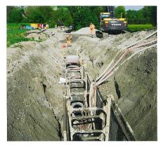
Abb. 13: Neue Hauptleitung zum Entwässerungspumpwerk in 4 m Tiefe.
