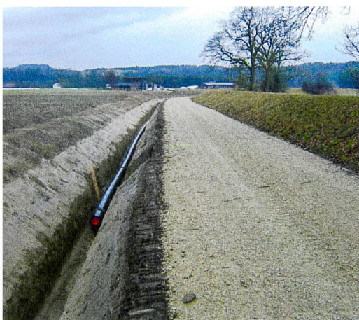
Abb. 17: Bau der Versorgungsleitung.
