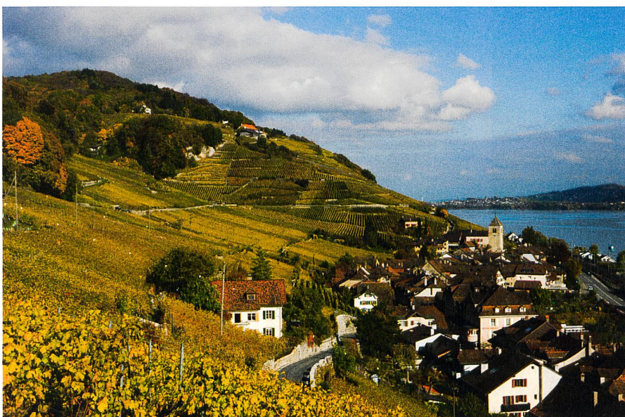
Abb. 2: Eine der ältesten Kulturlandschaften der Schweiz ist das BLN 1001 linkes Bielerseeufer. Wann soll von der Belastung durch die Autobahn befreit werden. Dazu ist ein Bauprojekt mit einem Umfahrungstunnel geplant, welches noch landschaftsverträglicher ausgestaltet werden muss (Bild: Andreas Gerth).
