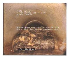
Abb. 1: Bei Kanal-TV festgestellter Wurzeleinwuchs.
