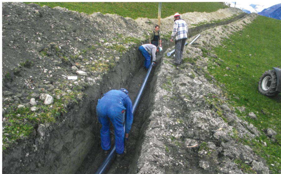
Abb. 3: Verlegung der Rohre.
