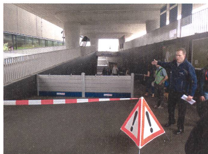
Abb. 3: Objektschutz gegen das Hochwasser der Sihl mit mobilen Elementen in der Stadt Zürich.
