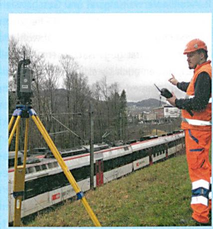
**Abb. 1: Bestimmung LV03 Koordinaten von Passpunkt mittels freier Station auf Gleisversicherungen (Bild: Stefan Gasser, SBB AG, I-PJ-ENG-FBG-KCGM-ZUE, Vulkanplatz 11, 8048 Zürich, stefan.gasser2@sbb.ch).**
