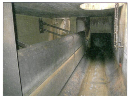
Abb. 2: Hochwasserentlastung in San Nazzaro (Sciarini SA).
