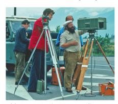
Abb. 7: EDM mit AGA Geodimeter 8 des IGP 1975 mit W. Schneibel (Operateur) und W. Fischer, Projektleiter (l.) (Foto: S. Heggli).
