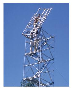
Abb. 10: Aufbau des mobilen Messturms (Höhe bis 24 m) der L+T im Kanton VD (Foto: L+T).
