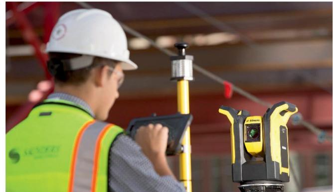
ungehinderter Sicht in der Vertikalen schnell ein Deckenlayout übertragen. Die automatische Einrichtung (Autostationing) der Station ermittelt auf Knopfdruck die Position des Instruments auf der Baustelle. So ist das System schneller einsatzbereit und erfordert weniger Fachkenntnisse als bisher verfügbare Lösungen.
