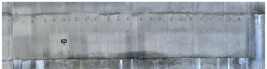
Fig. 8: Résultat d'une ortho-photo, composée d'une trentaine d'images.
