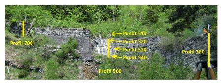
Abb. 2: Schwergewichtsmauer im Gebiet «In Brüchen» mit den Profilen 300, 500 und 700 zur Bestimmung der Kippungen.
