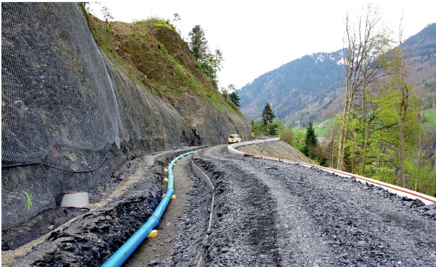
Abb. 2: Bau der Taminabrücke 2013-2017, inklusive Verbindungsstrasse.
