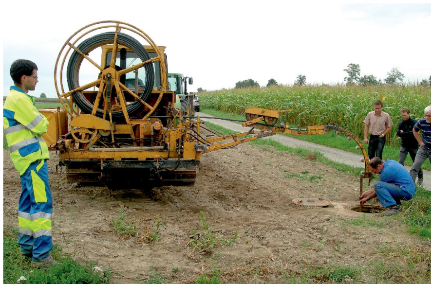
Abb. 3: Spülen einer Drainagesammelleitung (Bild: W. Wehrli).
