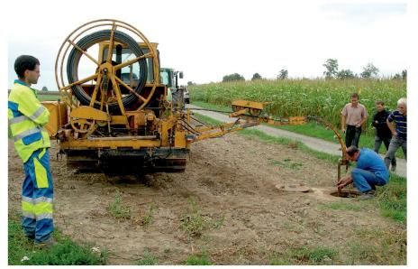
Abb. 3: Spülen einer Drainagesammelleitung (Bild: W. Wehrli).
