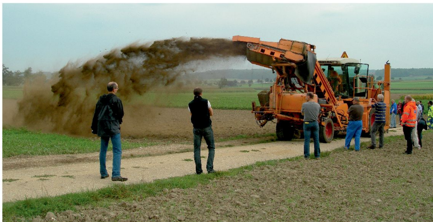
Abb. 4: Bankettfräse im Einsatz (Bild: W. Wehrli).
