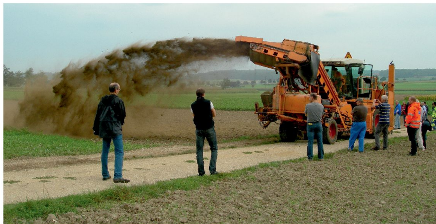
Abb. 4: Bankettfräse im Einsatz (Bild: W. Wehrli).
