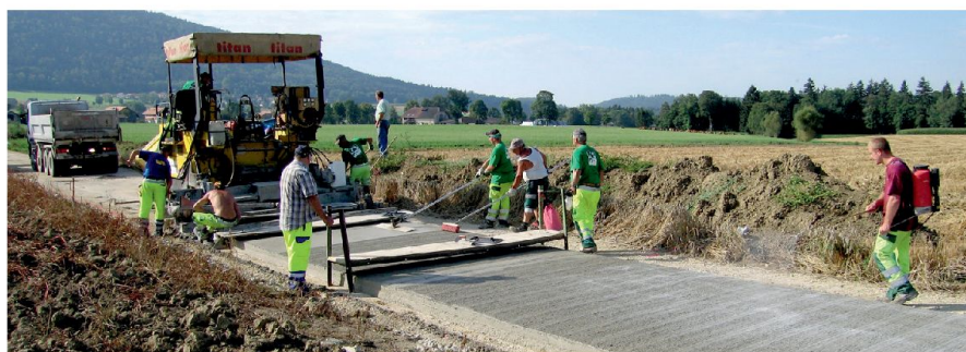
Fig. 6: Bétonnage d'un chemin à Engollon, 2012.
