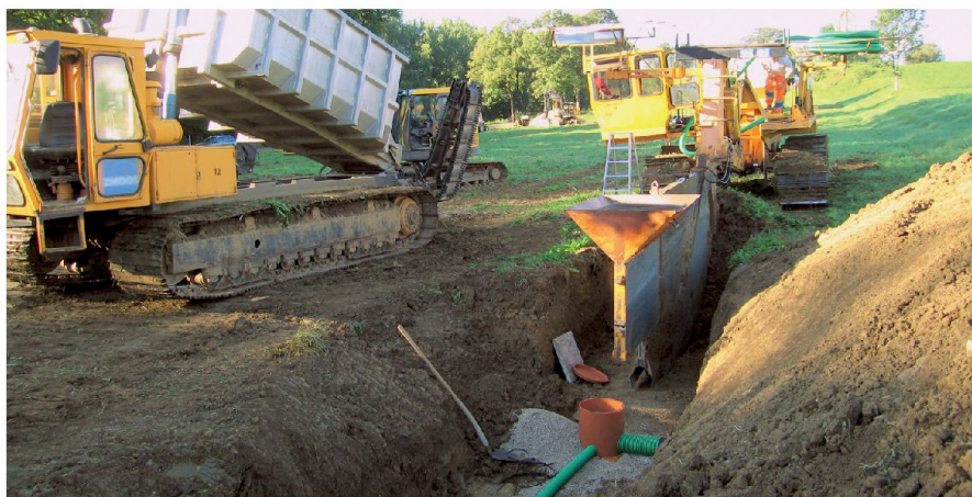
Fig. 5: Travaux de drainages à Engollon, 2011.
