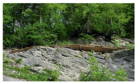
Abb. 7: Das weitgehend zerstörte Strassentrassee durch den südlichen Steinbruch wurde mit einem modernen Steg überbrückt. Dieser ist wegen der durch Steinbrucharbeiten destabilisierten Felsformationen unterhalb des Trassees direkt in der Felswand verankert und schwebt so gleichsam über dem ursprünglichen Trassee (Cornel Doswald 2012).
