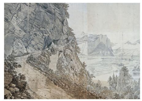
Abb. 4: Jan Hackaerts bekannte Zeichnung der Hohwand ist die älteste bildliche Darstellung der Schollbergstrasse. Sie zeigt exemplarisch die unterschiedlichen Elemente des Ausbaus mit Halbgalerie, Brücke, Stützmauer, Brüstungsmauer oder Flechtzaun, erdiger Fahrbahn im Flachen und Pflästerung auf der Gefällsstrecke (Ausschnitt nach: JAN HACKAERT, Die Schweizer Ansichten, 1653-1656, bearb. und kommentiert von Gustav Solar. Dietikon-Zürich 1981, Tf. 14).
