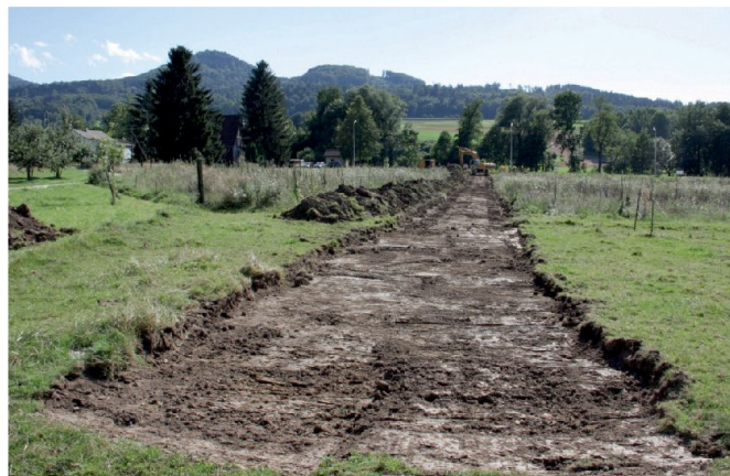
Abb. 4: Erdarbeiten im Rahmen eines Wegebaus bei sehr trockenen Verhältnissen und leistungsfähigen Maschinen (GM Wahlen).
