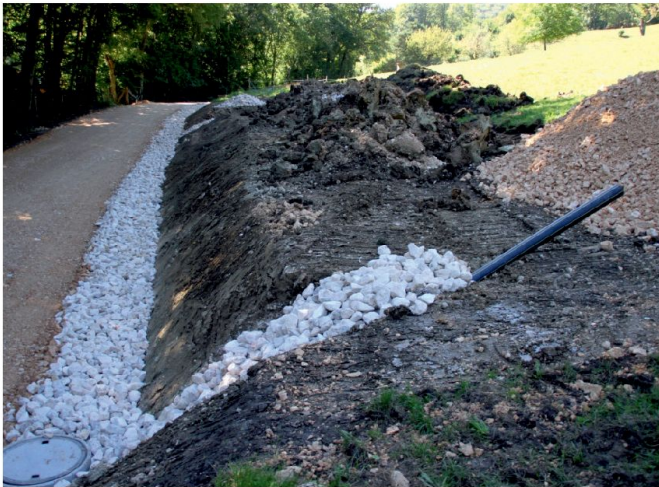
Abb. 5: Einbau einer Drainage mit geringer Flächenbeanspruchung (GM Wahlen).
