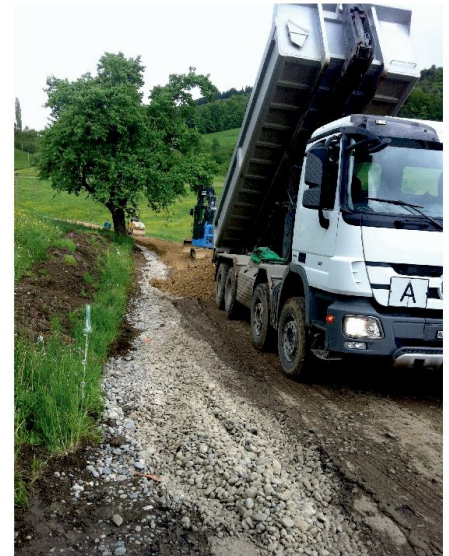
Abb. 1: Ausbau Weg mit Wegentwässerung, A-Horizont (Neueten, Niederdorf BL).
