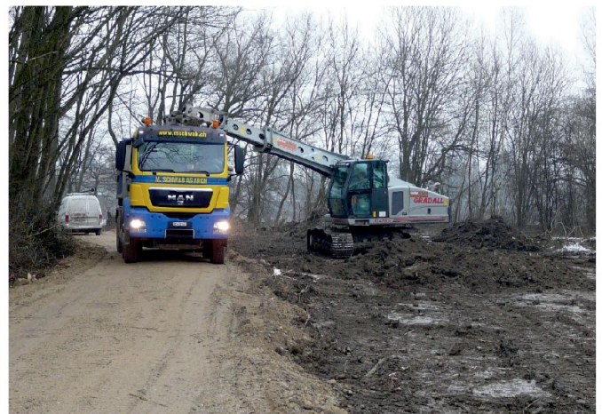
Abb. 8: Dank der Baupiste können Transporte wetterunabhängig vorgenommen werden.
