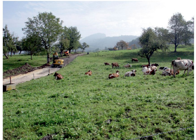
Abb. 6: Wegsanierung, bei der bestehende Strukturen nur geringfügig beeinträchtigt werden (GM Wahlen).
