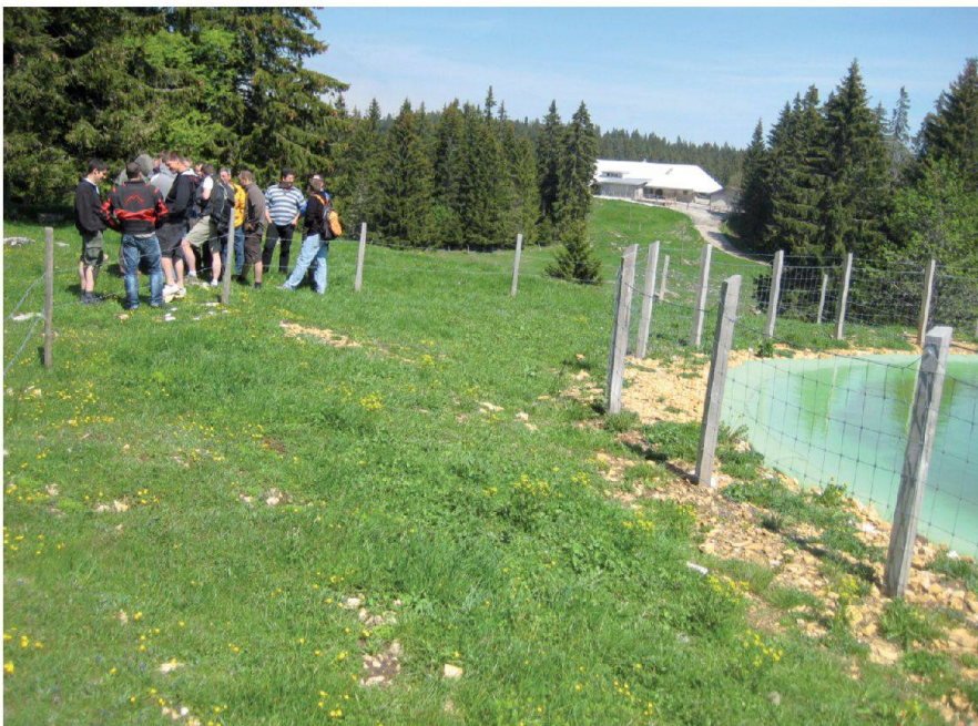
Fig. 1: Alpage du Cerney VD: Etang bâché permettant la récupération de l'eau pluviale pour l'alimentation du bétail dans le Jura vaudois.
