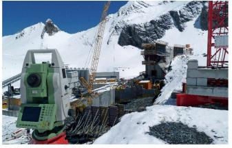
Abb. 4: Netzmessung im Zugangsstollen 1.
