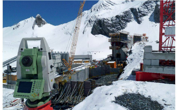
Abb. 5: Schalungskontrolle Staumauer Muttsee.
