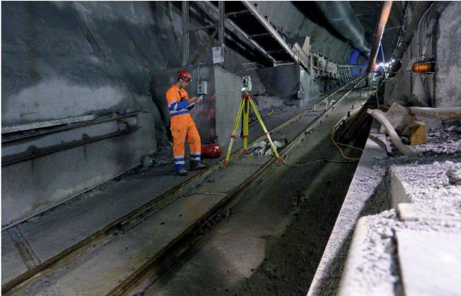
Abb. 4: Netzmessung im Zugangsstollen 1.
