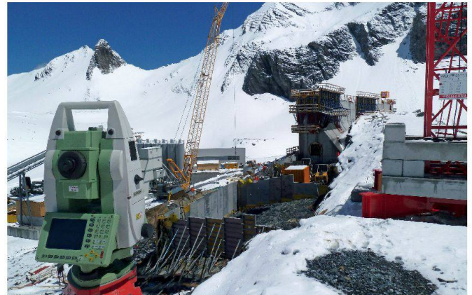
Abb. 5: Schalungskontrolle Staumauer Muttsee.
