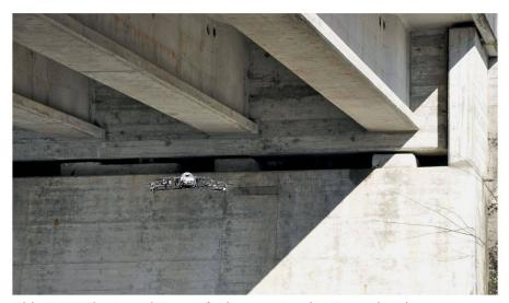
Abb. 5: UAV bei Inspektionsaufnahmen unter der Kronenbrücke.
