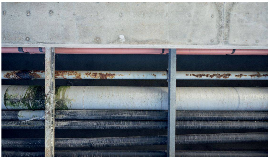
Abb. 6: Untersicht mit Werkleitungen aus der Sicht des Foto-Kopters.
