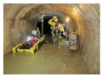
Abb. 4: Wasserschutz für Materialdepot.
