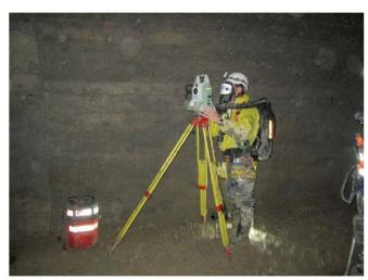
Abb. 2: Tachymetermessung mit Atemschutzgerät.
