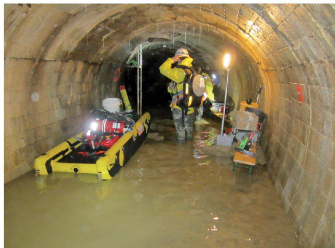
Abb. 4: Wasserschutz für Materialdepot.
