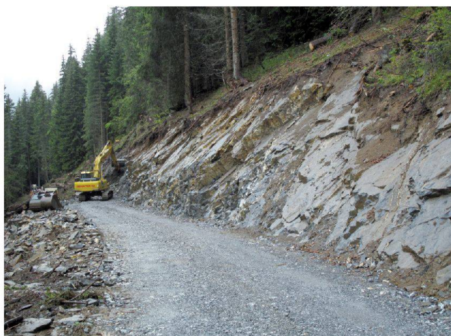
Abb. 6: Wegebau mit bergseitigem Felsabtrag (Sommer 2011).
