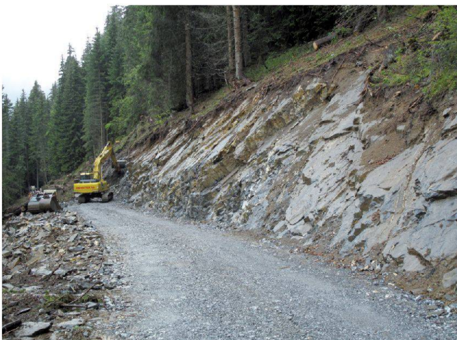
Abb. 6: Wegebau mit bergseitigem Felsabtrag (Sommer 2011).
