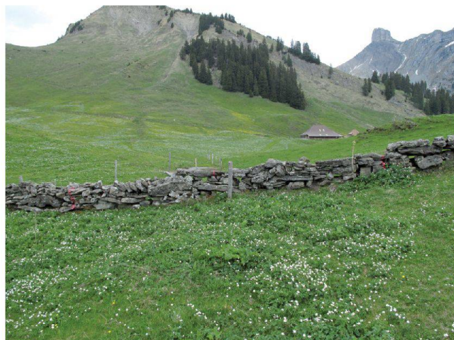
Abb. 2: Typische Weidemauer auf Iselten, vermutlich grösstenteils im 19. Jahrhundert errichtet. Der Mauerabschnitt, welcher für den Wegebau abgebrochen werden musste, ist mit roter Farbe markiert. Im Hintergrund die Alphütte im Gebiet Bromatta der Alpengenossenschaft Inner-Iselten.
