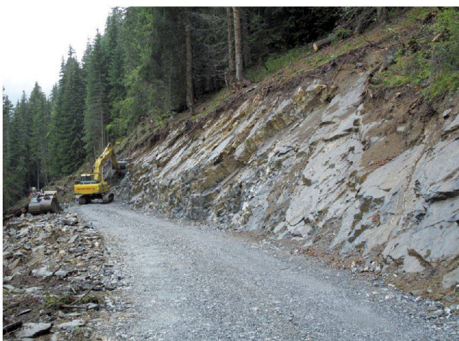
Abb. 6: Wegebau mit bergseitigem Felsabtrag (Sommer 2011).
