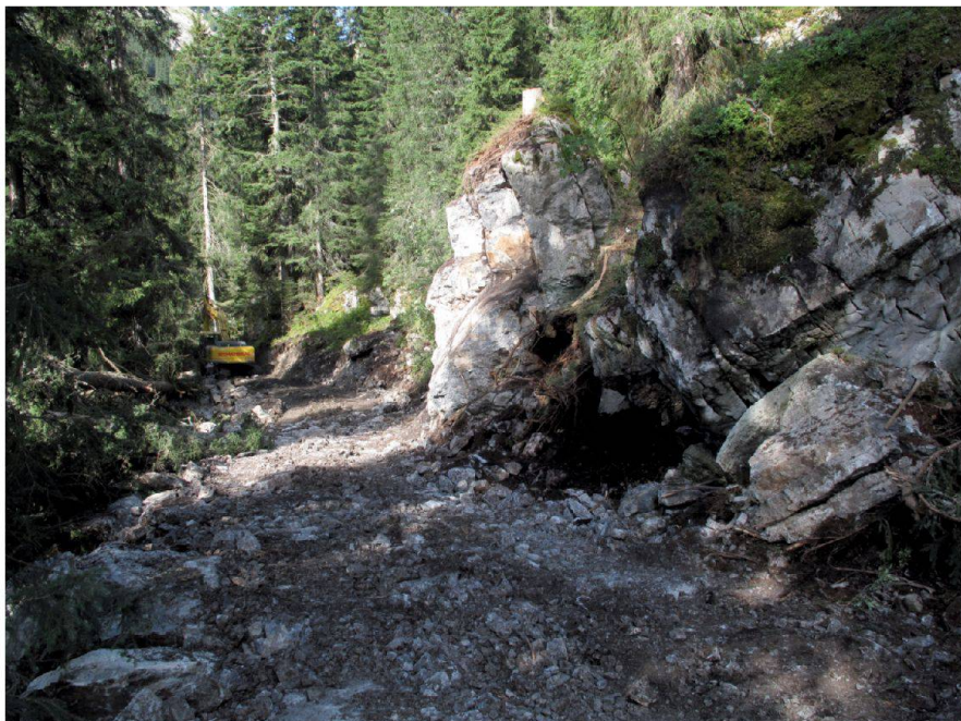
Abb. 5: Wegebau durch den Schiltwald im Herbst 2010. Die Wegführung wurde soweit möglich an die Gegebenheiten angepasst. Einzelne Felsblöcke mussten dennoch weggesprengt werden.
