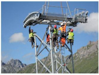
Fig. 5: Grand Clé – assemblage tête du pylône P3.
