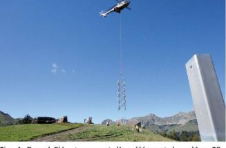
Fig. 4: Grand Clé – transport d'un élément du pylône P3.
