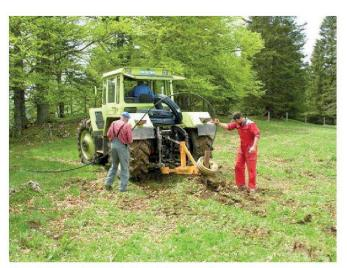
Fig. 7: Pose de conduites à la sousoleuse.
