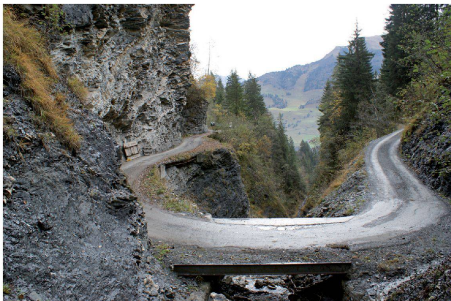
Abb. 3: Querung Gempelegrabe; Zustand bis Frühjahr 2010.
