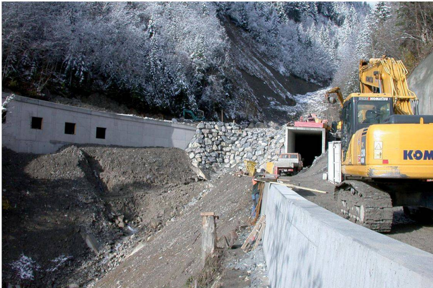
Abb. 4: 1. Etappe: Galerie Zwüschebachgrabe im Rohbau, Oktober 2009. Fig. 4: 1. étape: gros-œuvre de la galerie du Zwüschebachgrabe en cours de construction, octobre 2009.
