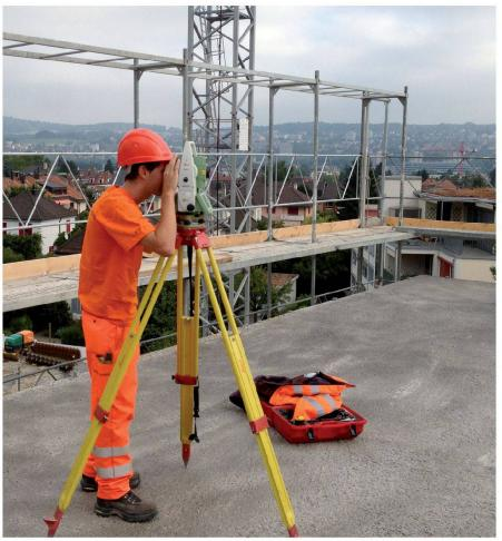
Abb. 3: Ein Mitarbeiter von Geomatik + Vermessung bei der Bauvermessung. Fig. 3: Un collaborateur de Géomatique + Mensuration lors de mesures d'une construction.
