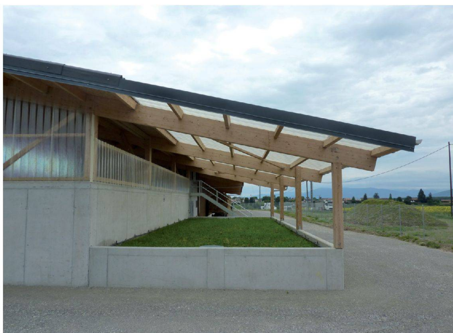
Fig. 2: Installation pour la biodégradation des matières actives.
