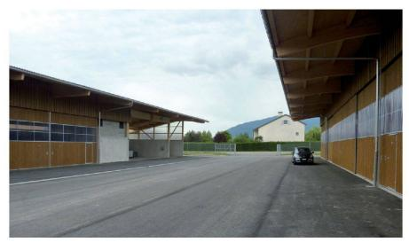
Fig. 3: Vue sur les hangars. Chaque travée comporte une cellule identique fermée par une porte coulissante.
