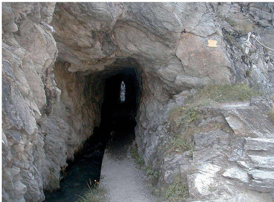
Abb. 2: Eggerberg-Gorperi-Stollen und Trasse alte Suone.
