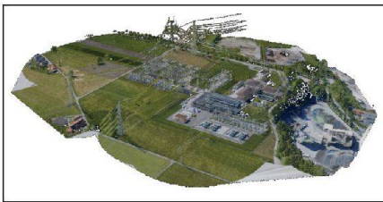
Abb. 2: Kombinierte Laserdaten- und Luftbilddarstellung einer Trafostation mit Zubringerleitungen.
