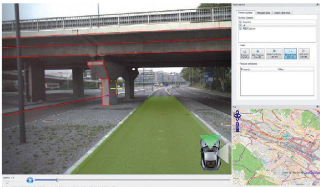
Abb. 9: Autobahnbrücke aus Perspektive MMS.
