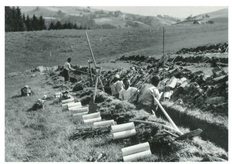
Abb. 2: Rüeggisberg 1944. Aushub der Drainagegräben von Hand<sup>2</sup>.
