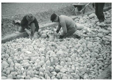
Abb. 8: Gesamtmelioration Ersigen-Oberösch-Niederösch. Wegbau, manuelles Versetzen des Steinbettes, 1942.
