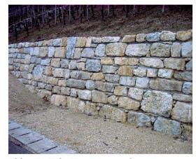
Abb. 5: Rebgüterzusammenlegung Twann-Ligerz-Tüscherz-Alfermé. Der nach langen Diskussionen gefundene Kompromiss für den Mauerbau Typ Twann: unregelmässig grosse Steine auf Mörtel gebettet, Vertikalfugen Mörtel-frei.
