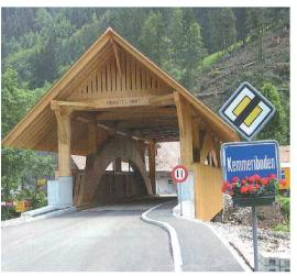
Abb. 4: Gedeckte Holzbrücke über die Emme, hinüber zum Kemmeribodenbad, Schangnau, 2009.
