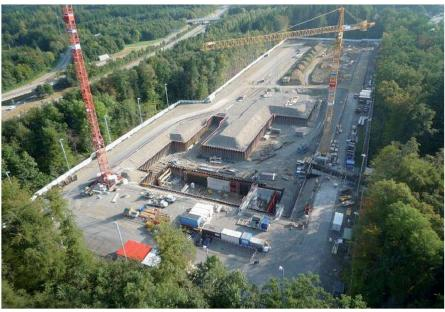
Abb. 2: Blick in die Baugrube, gut sichtbar die umfangreichen Spundwände.
