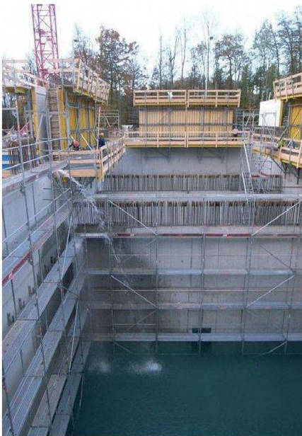
Abb. 3: Der teilweise mit Wasser gefüllte Kehrichtbunker während den Setzungsmessungen.
