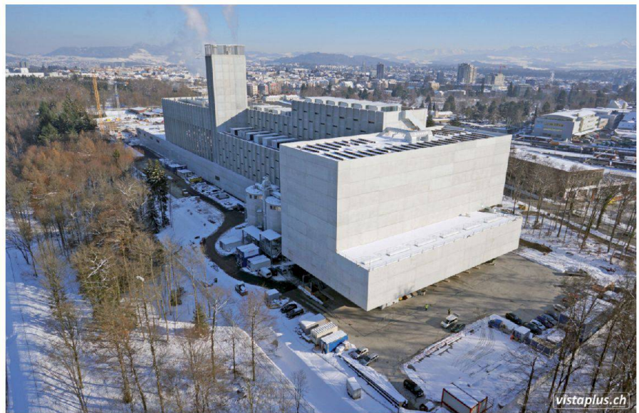
Abb. 1: Das Gebäude, wie es sich am Ende des vergangenen Jahres präsentierte, Blickrichtung Stadt Bern. Die Bauarbeiten sind praktisch abgeschlossen.
