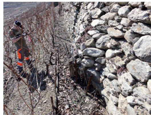
Fig. 1: Relevé d'un dégât présentant un parement bombé.
