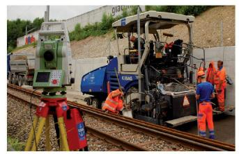
Abb. 4: 3D-Steuerung Einbaumaschine mit Totalstation. Fig. 4: Pilotage 3D d'une machine de pose de revêtement avec station totale.
