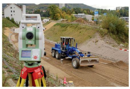
Abb. 6: 3D-Steuerung Grader mit Totalstation.
