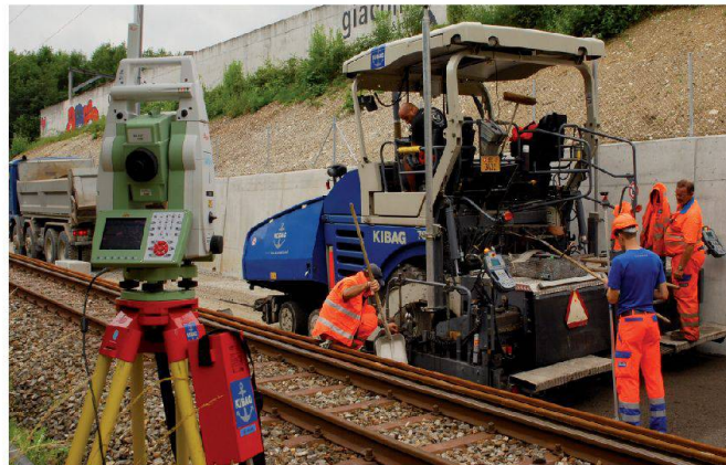
Abb. 4: 3D-Steuerung Einbaumaschine mit Totalstation. Fig. 4: Pilotage 3D d'une machine de pose de revêtement avec station totale. Fig. 4: Comando 3D di una macchina di posa con stazione totale.
