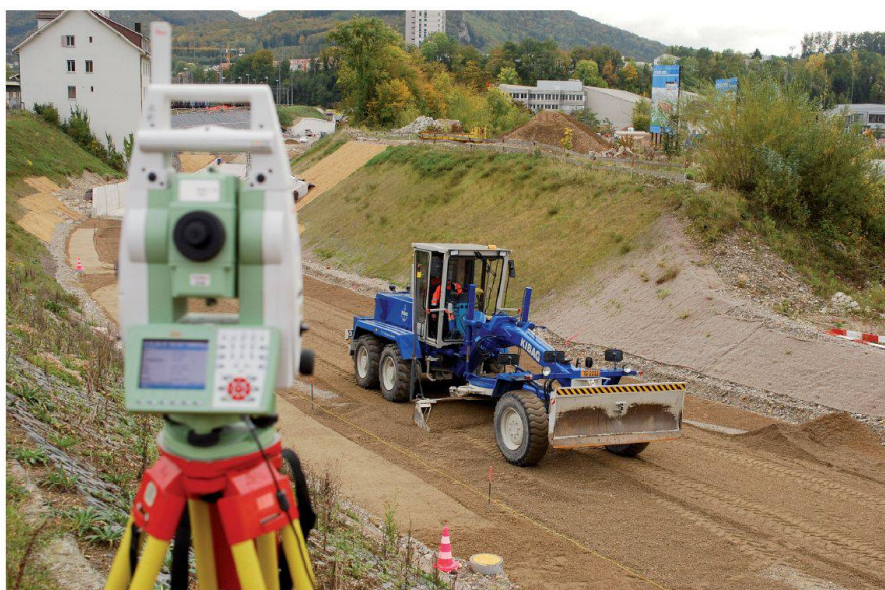
Abb. 6: 3D-Steuerung Grader mit Totalstation. Fig. 6: Pilotage 3D d'une niveleuse avec une station totale. Fig. 6: Comando 3D di una livellatrice con stazione totale.
