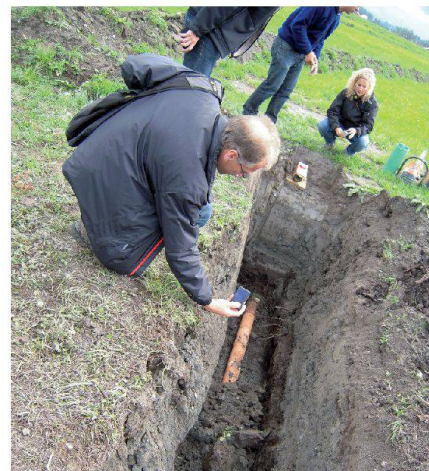
Abb. 2: Die fertig eingelegte Saugerleitung wird stufenweise eingedeckt. Mit dem Laser-Gerät wird das Soll-Gefälle für den Einbau markiert.
