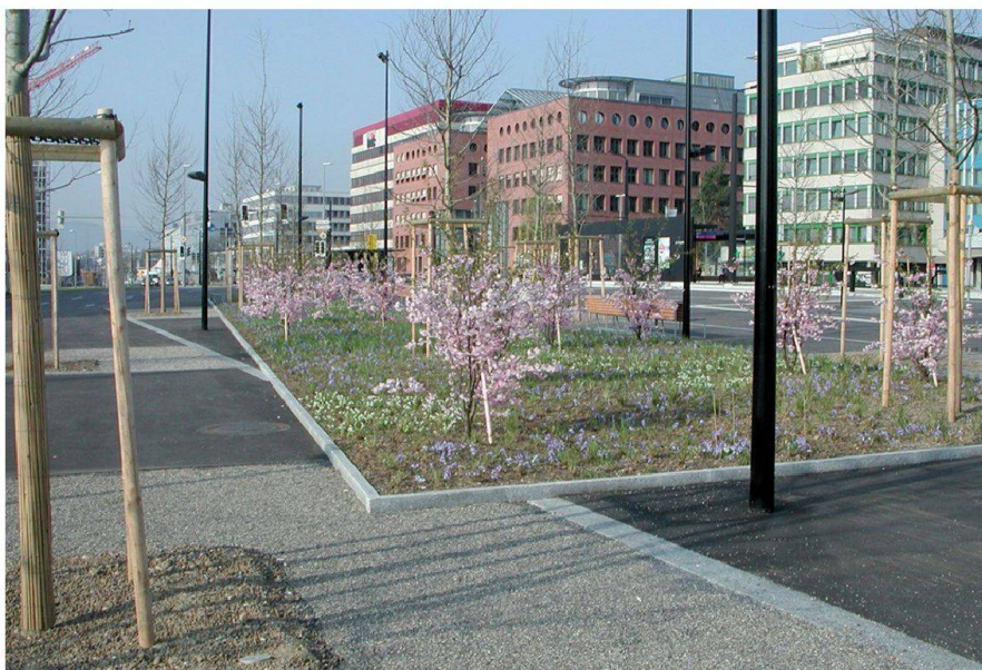
Abb. 5: Wie selbstverständlich wirkt eine erfolgreiche Umsetzung der Koordinationsarbeit am Beispiel des Lindberghplatzes, wenn sie von allen Beteiligten gepflegt wird (Foto: Rainer Klostermann).
