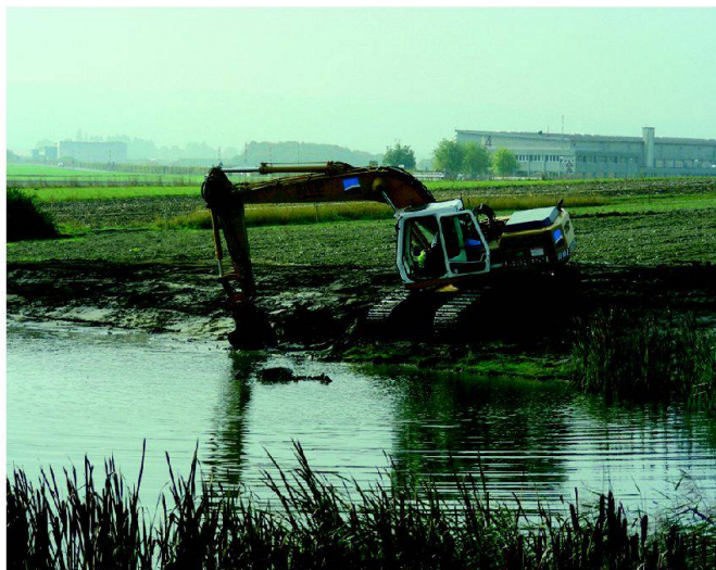
Fig. 2: Pré Bovet: terrassement 2004.
