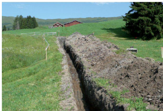
Fig. 4: Nouveau réseau ménageant l'environnement au bord d'un bas-marais, avec un empiètement minimum sur ce dernier.
