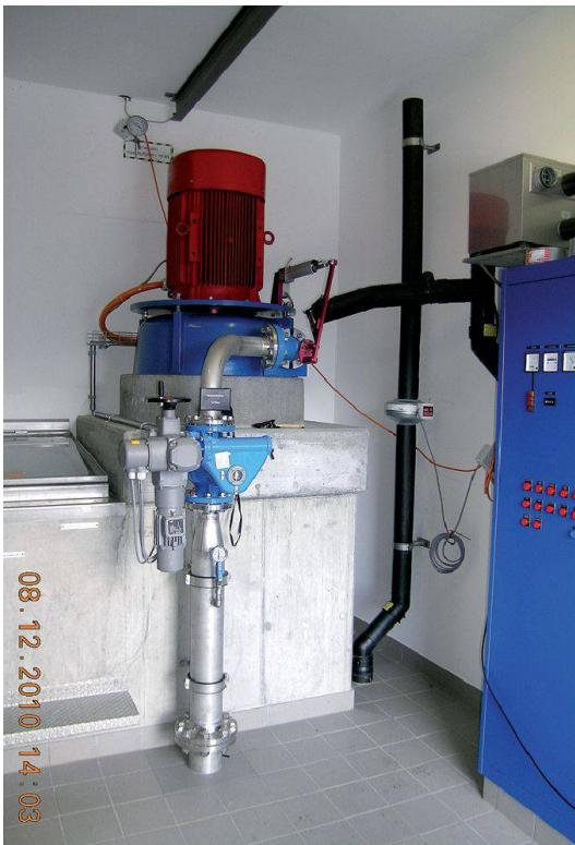
Abb. 2: Pelton-Turbine, Generator und Schaltschrank im Reservoir mit minimalem zusätzlichem Platzbedarf.
