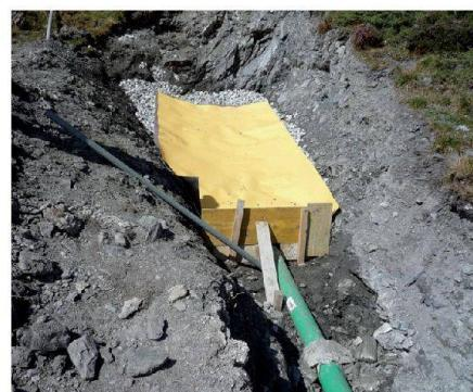
Fig. 3: L'assainissement des captages de source au bord des bas-marais nécessite des constructions particulièrement précises et les indications d'un suivi écologique des travaux.
