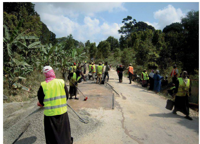
Abb. 4: Strassenabschnitt kurz vor dem Auftragen des letzten Layers.
